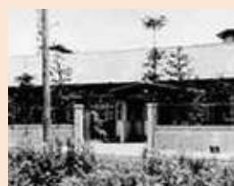
1951年 旧幼稚園舎 木造平屋建
