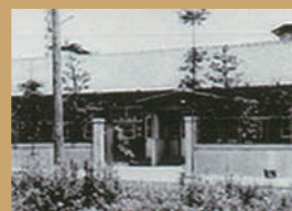
1951年 旧幼稚園舎 木造平屋建
